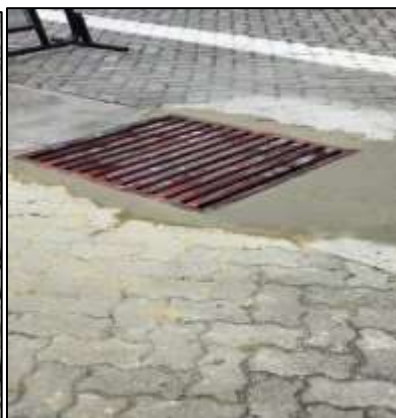
6.1.8 Mantenimiento y reparaciones a levantamiento de adoquines. FECHA: 28/02/2024
