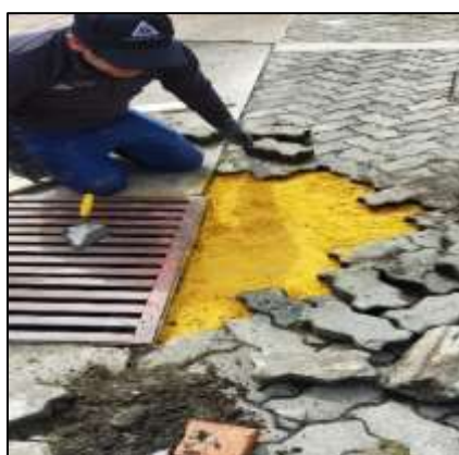
6.1.8 Mantenimiento y reparaciones a levantamiento de adoquines. FECHA: 28/02/2024
